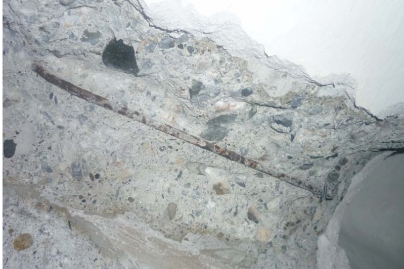
FOTO 5.- CALICATA EN FORJADO PLANTA 1
