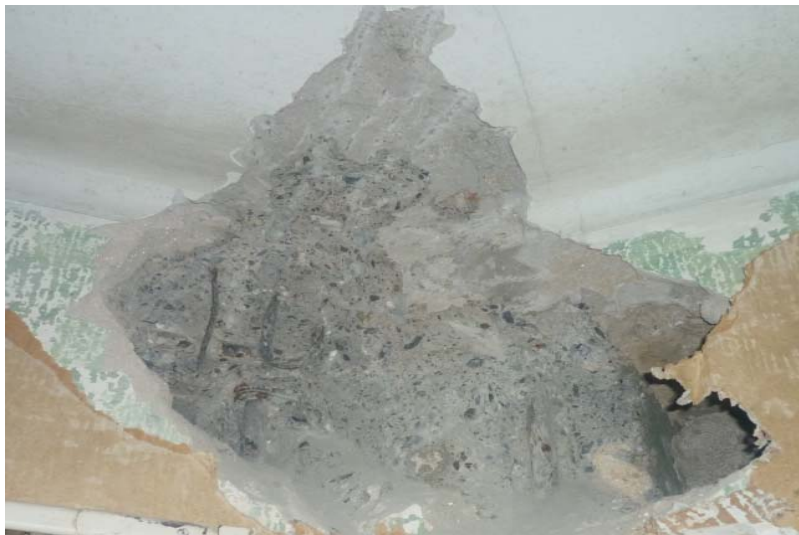
FOTO 10.- CALICATA EN FORJADO PLANTA 4
