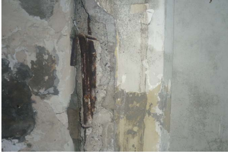
FOTO 3.- CALICATA EN PILAR PLANTA 4
