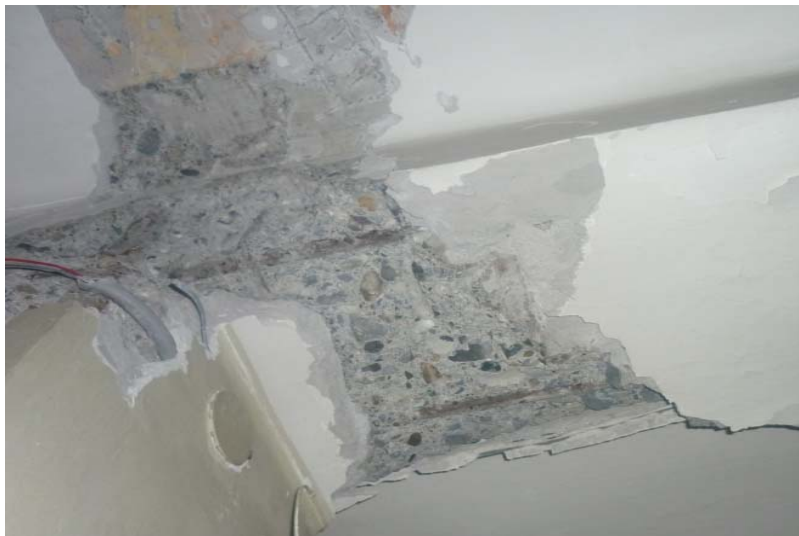
FOTO 4.- CALICATA EN FORJADO PLANTA 1
