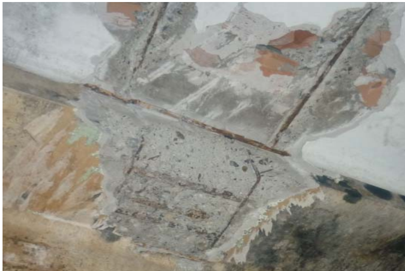
FOTO 12.- CALICATA EN FORJADO PLANTA 4
