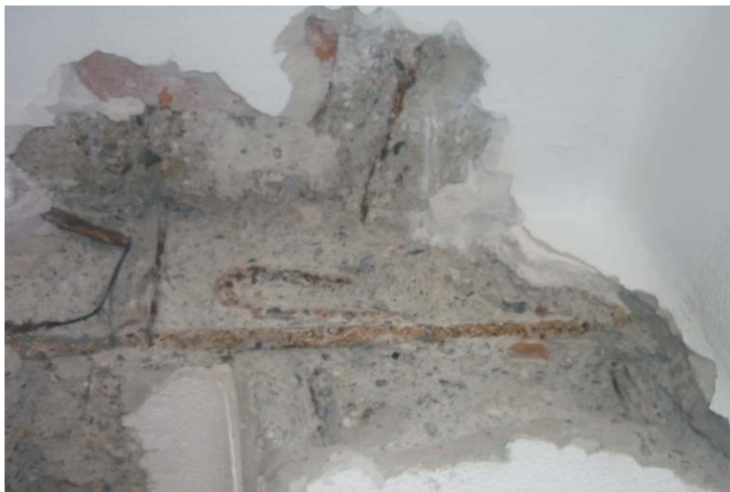
FOTO 8.- CALICATA EN FORJADO PLANTA 2
