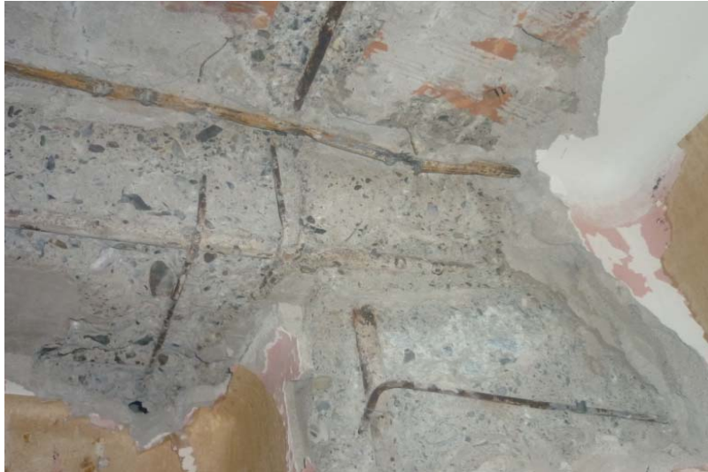
FOTO 9.- CALICATA EN FORJADO PLANTA 4
