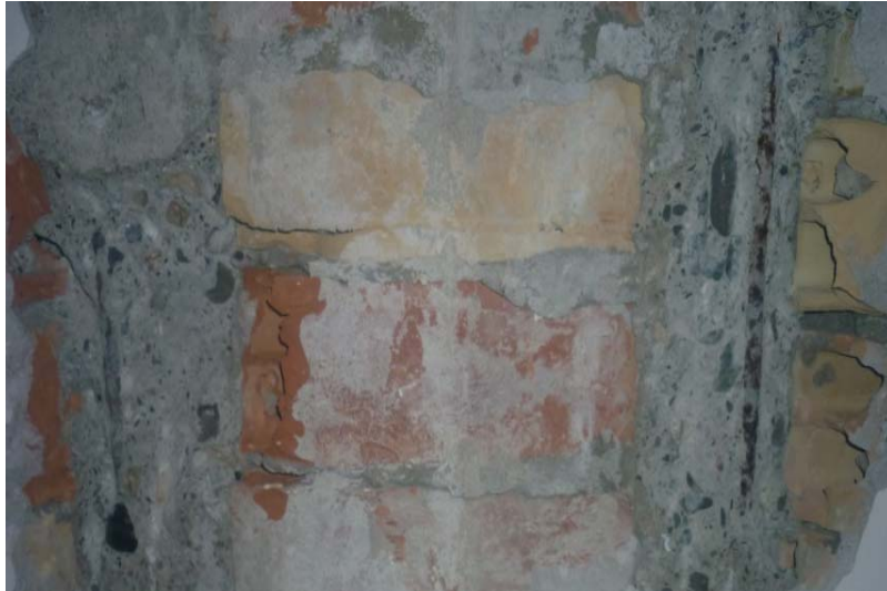
FOTO 7.- CALICATA EN FORJADO PLANTA 1
