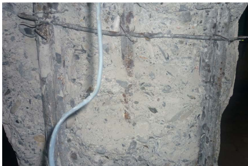
FOTO 2.- CALICATA EN PILAR PLANTA 1
