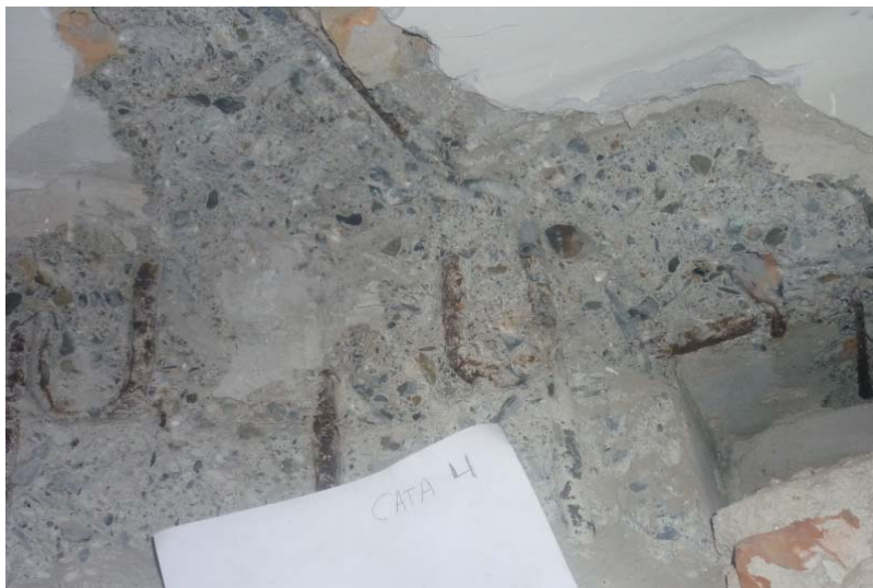
FOTO 6.- CALICATA EN FORJADO PLANTA 1
