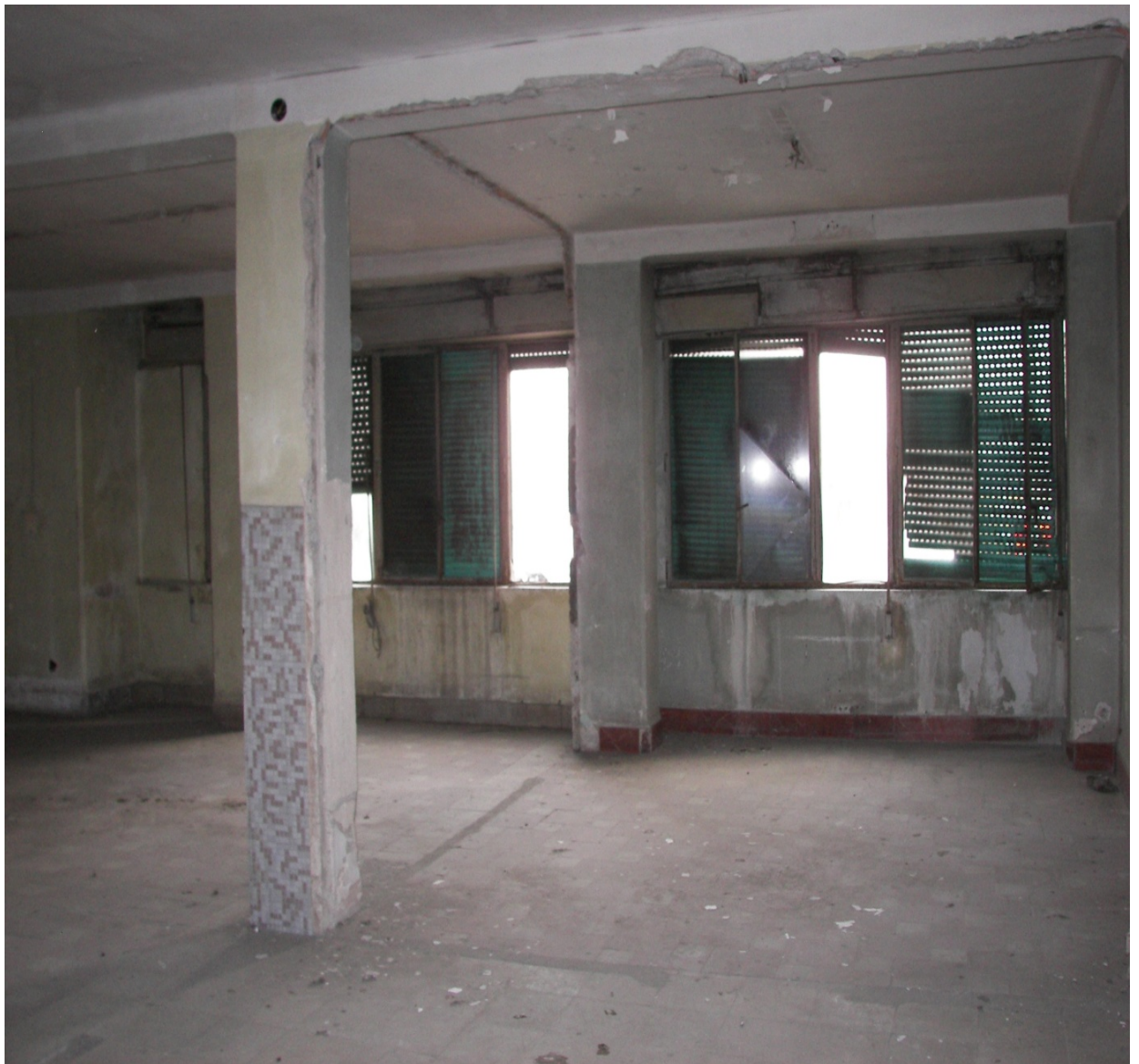
FOTO 3.LOCAL PRIMERA PLANTA. Vista general del local de la primera planta inspeccionado.
