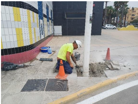
“Proyecto mejora del alumbrado de la avda. de la Hispanidad, calle Paseo de la Conferencia, Parque de la Conferencia y las zonas de Capitanía marítima”
