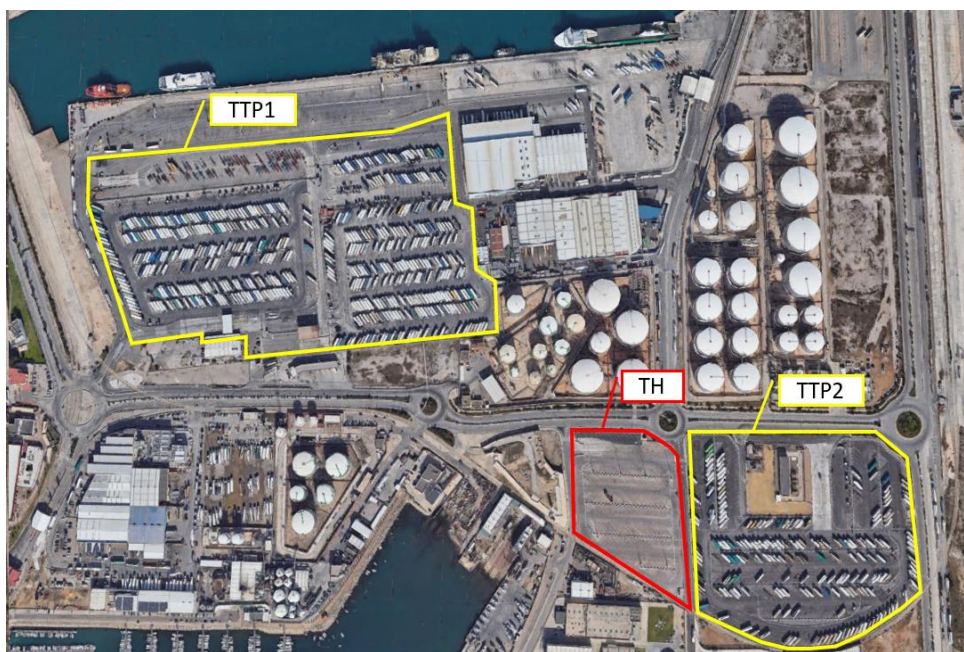
Fotografía nº 3: Zona actual de las áreas dedicadas al Tráfico Pesado en el Puerto Bahía de Algeciras (ATP)
