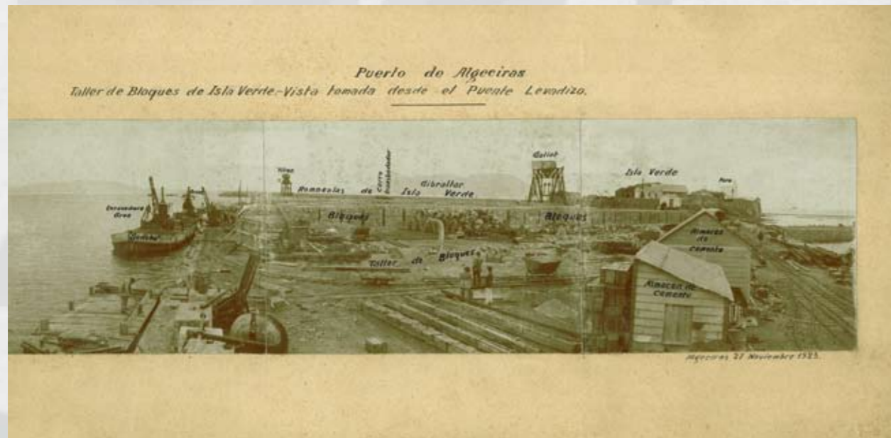
Taller de bloques de Isla Verde. Vista tomada desde el puente levadizo. 27 de noviembre de 1923. A.A.P.B.A.
