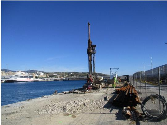
*Ilustración. Operaciones de micropilotaje del "Proyecto de adecuación de alineaciones del muelle nº 1 del Puerto de Tarifa".*
