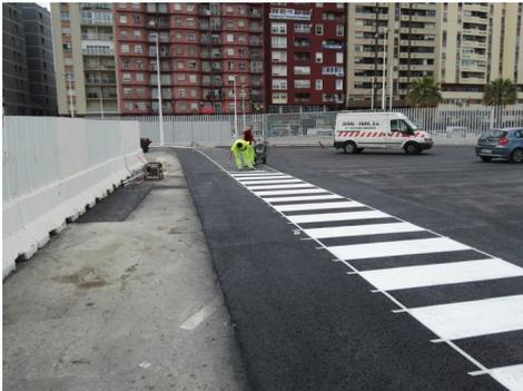
*Ilustración. Señalización horizontal con pintura Ecopicril del "Proyecto de acondicionamiento e integración de los espacios portuarios sin uso del Puerto de Algeciras. Fase II."*
