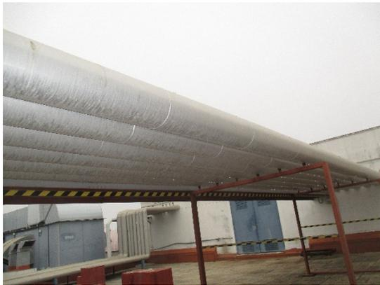
*Ilustración. Estado final de los conductos de impulsión y retorno instalados durante la ejecución del "Proyecto de adecuación de patinillos y conductos de impulsión y retorno en climatización en la estación marítima de Algeciras."*
