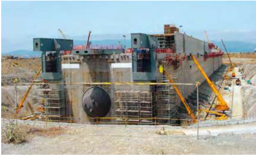
Construcción en Campamento del dique flotante para Mónaco.
