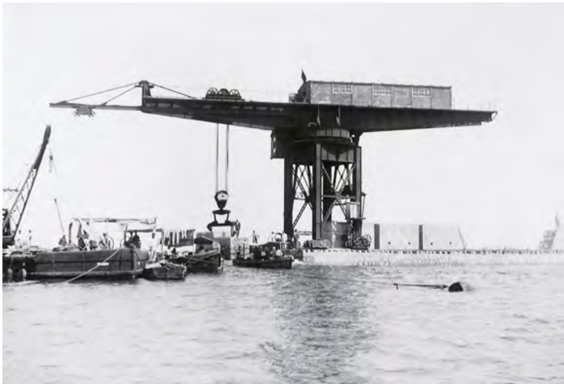
Titán colocando bloques en el dique norte en 1930.
