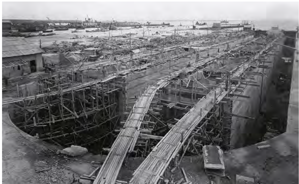
Construcción de un cajón en el dique seco de Cádiz en 1941. Colección J. A. Patrón.
