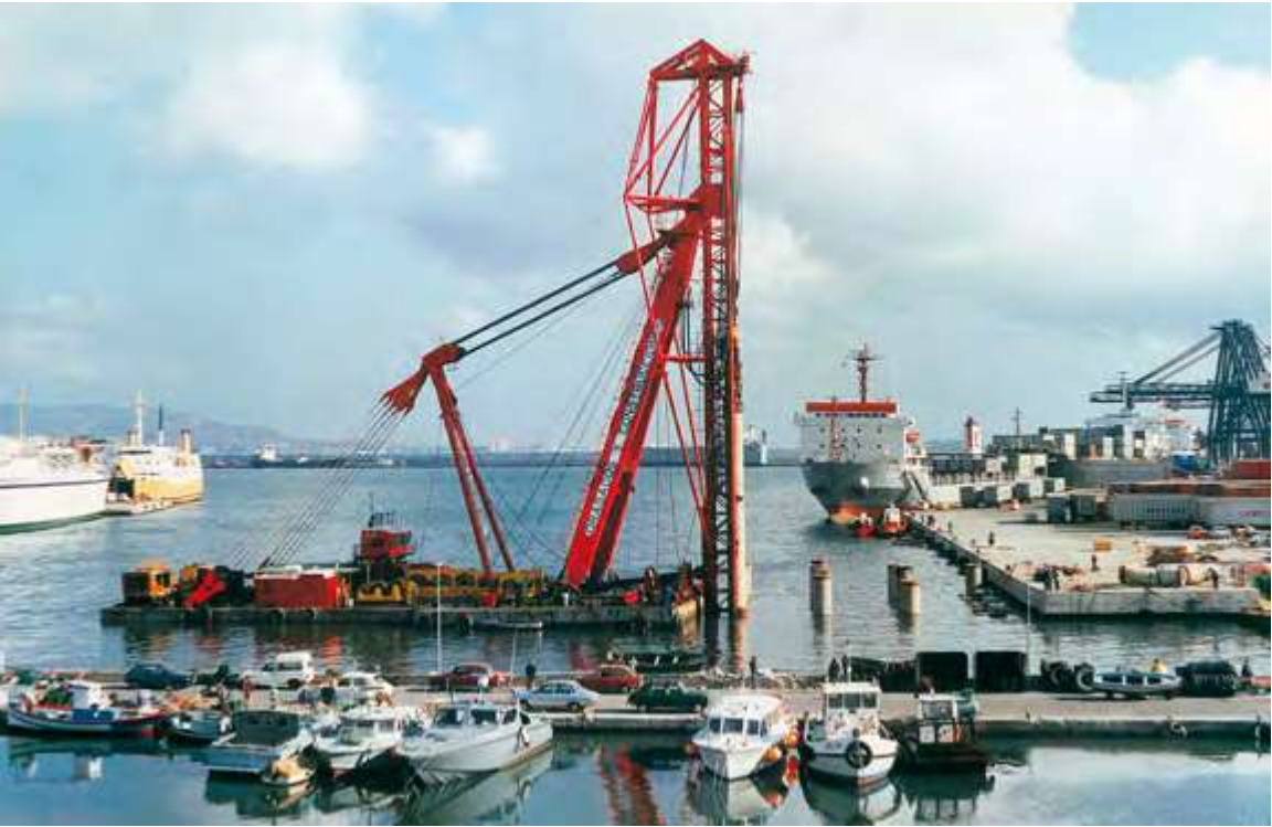
Cabria colocando pilotes en el muelle ro-ro de Isla Verde.
