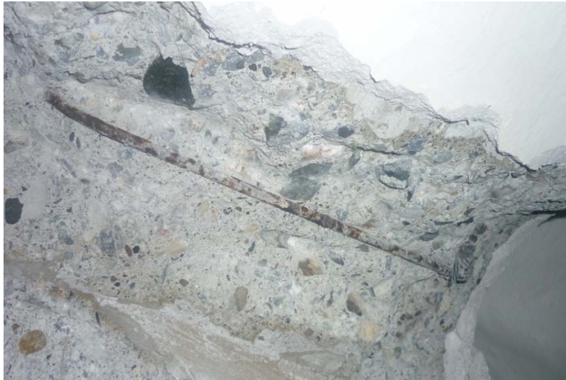
FOTO 5.- CALICATA EN FORJADO PLANTA 1
