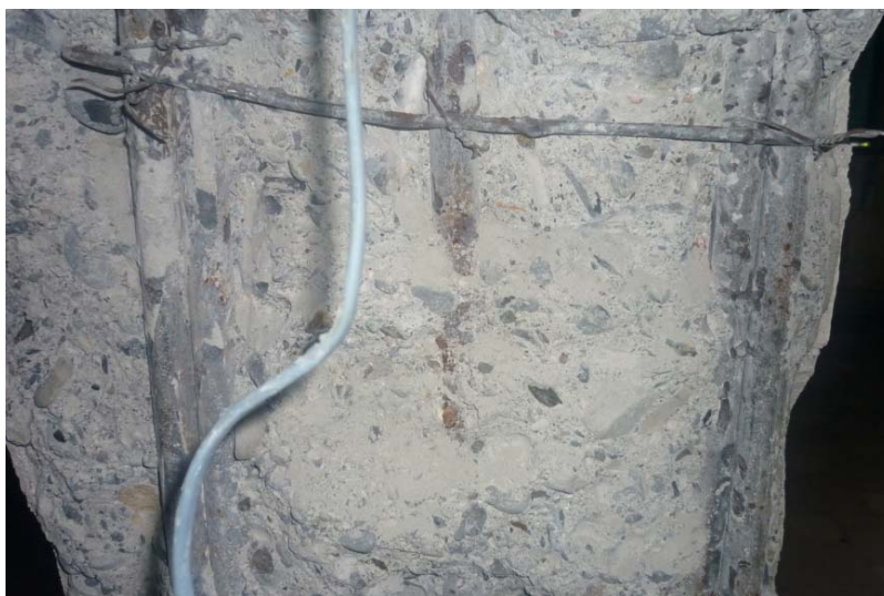
FOTO 2.- CALICATA EN PILAR PLANTA 1
