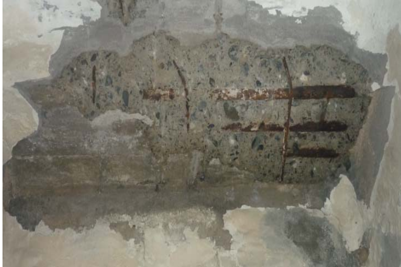
FOTO 13.- CALICATA EN VIGA FORJADO PLANTA 4
