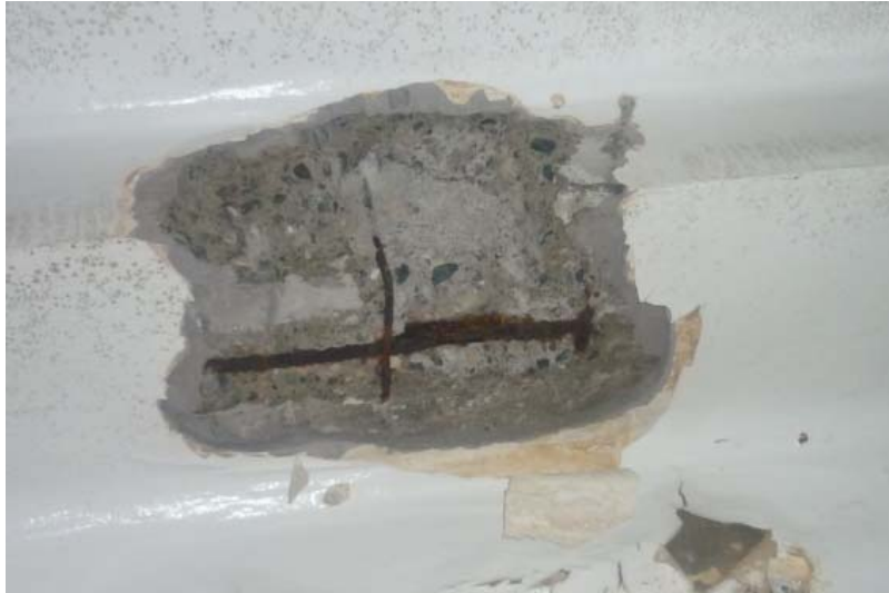
FOTO 11.- CALICATA EN VIGA FORJADO PLANTA 4
