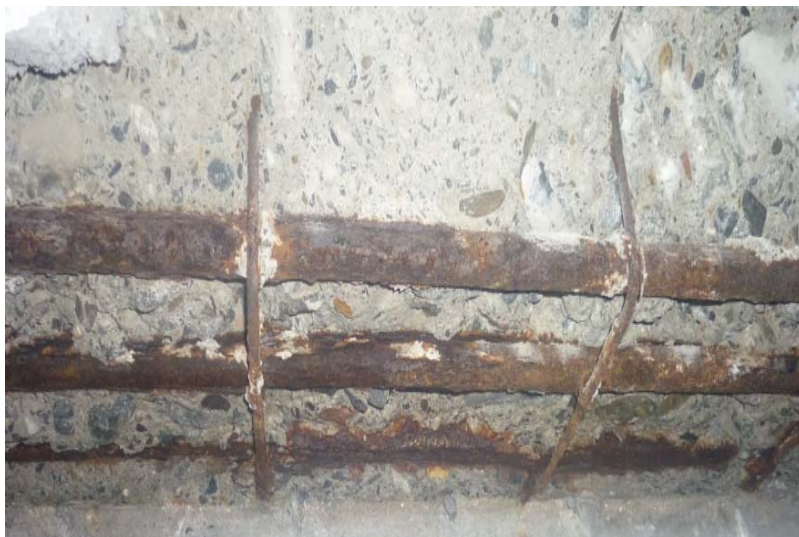
FOTO 14.- CALICATA EN VIGA FORJADO PLANTA 4
